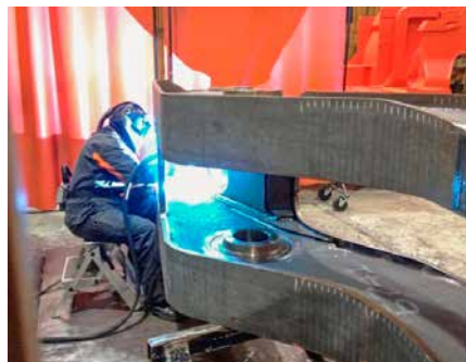
Kuva 1. Lastarin robottihitsattua prototyyppipuomia viimeistellään käsinhitsauksella Sandvik Mining and Constructionin Turun tehtaalla.
