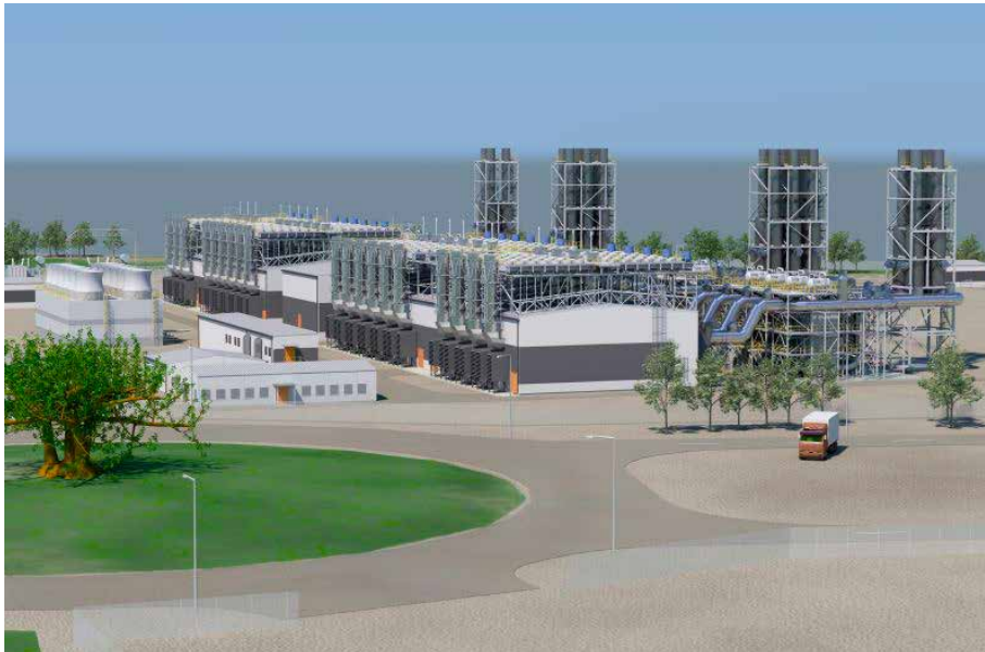
Malli tyypillisestä Wärtsilän toimittamasta voimalaitoskokonaisuudesta.
