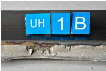
Kuva 9. S355 MC, liitosvirheitä ja huono tunkeuma.
