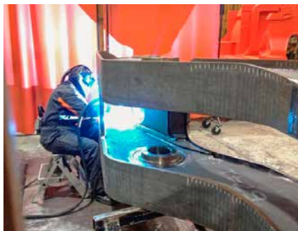
Kuva 1. Lastarin robottihitsattua prototyyppipuumia viimeistellään käsinhitsauksella Sandvik Mining and Constructionin Turun tehtaalla.
